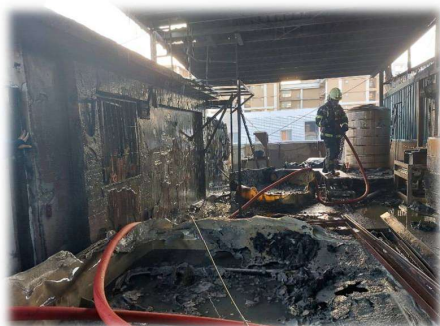
4樓佈線搶救情形
